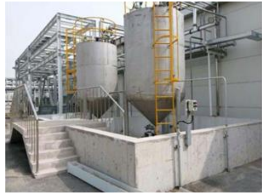
清洗废液地上储罐围堰
