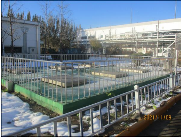
1 区化学品地下罐区
