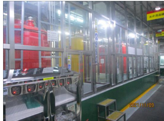
1区污水处理站药品室防泄漏截流沟及防护罩
