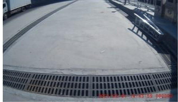
2 区罐区装卸区截流沟
