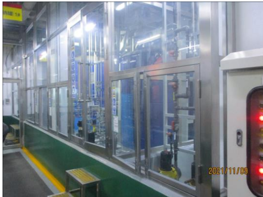
1区污水处理站药品室防泄漏截流沟及防护罩
