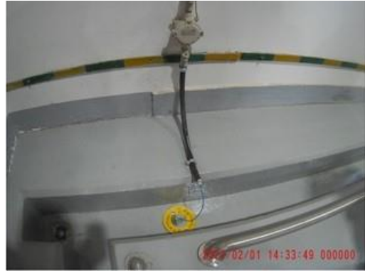
2区化学品仓库截流沟内泄漏报警装置
