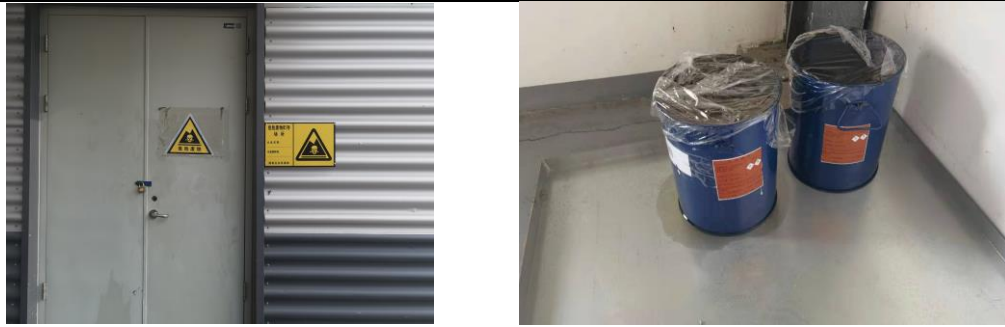
图8 现有危废暂存间规范化情况
