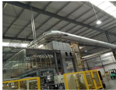
图11 集气罩+软帘组合密闭收集示意图
